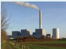
Elsam A/S, Studstrupværket, Denmark
